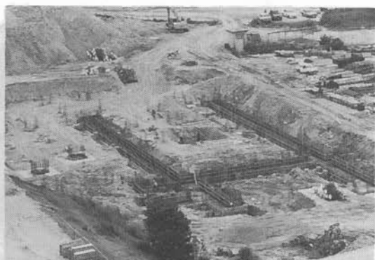
附属図書館建設工事
