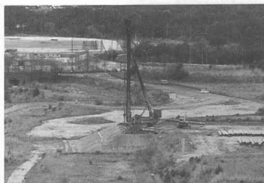
総合科学部建設工事
