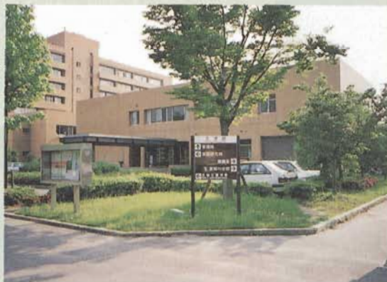
工学部玄関（事務・管理棟）
