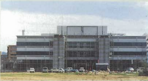
建設中の中央図書館
