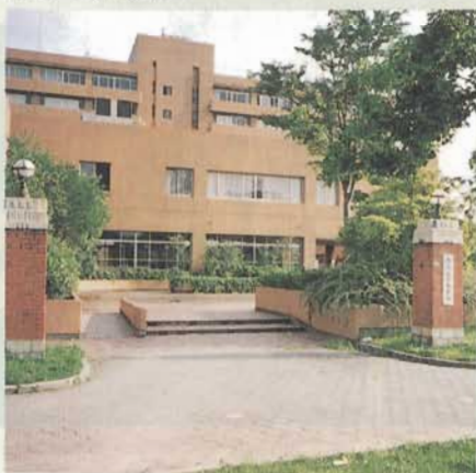
千田町キャンパスにあった正門の門柱（大正10年設置）も移転した
