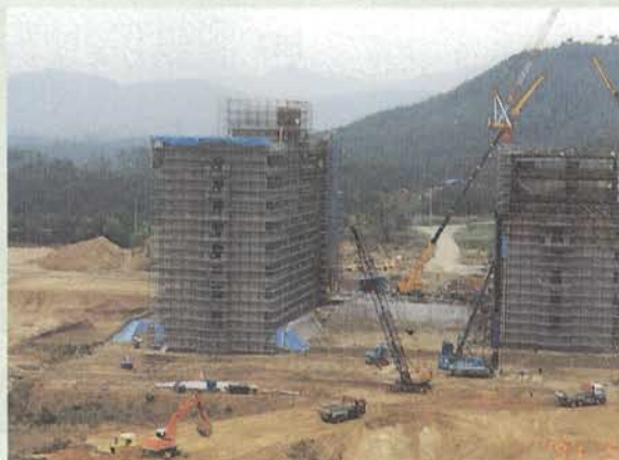
工学部屋上から西方に眺めた建設中の総合科学部研究棟A・C。その間に研究棟B、手前に講義棟、左手に西図書館予定地の工事の様子
