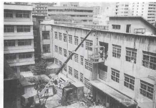
1991年8月26日東千田キャンパス3号館よりの積み出し
