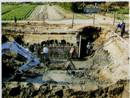
写真2 トレンチ発掘調査の現場 右手が海側の砂丘となり、調査をした畑は背後の低地にあたる。
