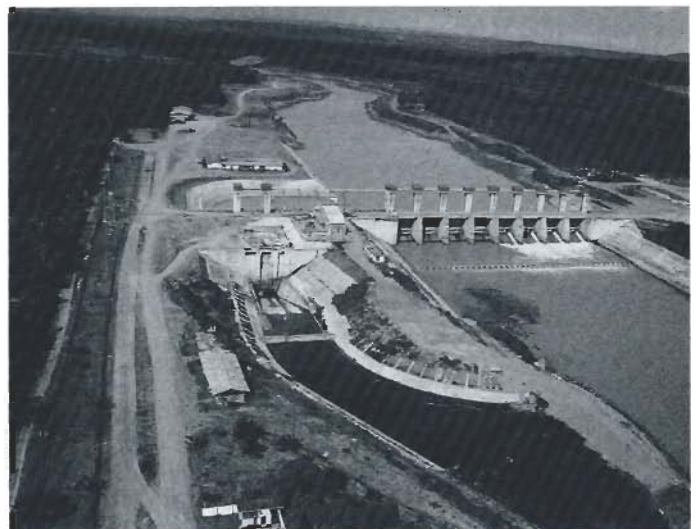
日本の援助で建設されたインドネシアのLodayoダム (JICA提供)
