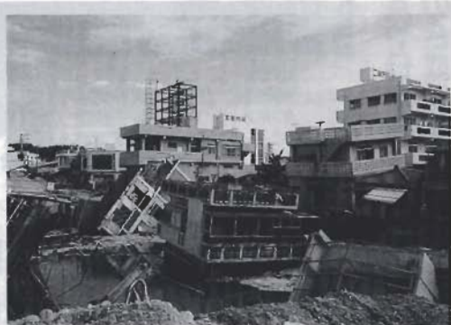
写真2 地下掘削現場の土留壁の大崩壊
