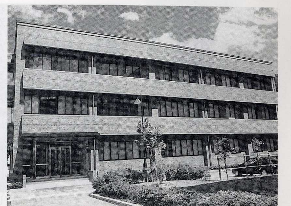
写真1 機器分析センター建物全景
